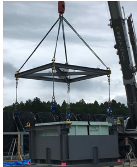
玉掛け・吊り上げ訓練
