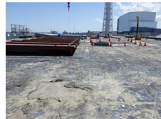
屋根ガレキ撤去の状況 〔北側から撮影〕
