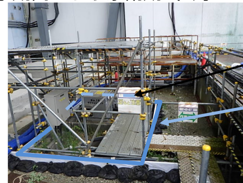
暫定対策後（7/14） （サブドレンNo.18ピット周辺）
