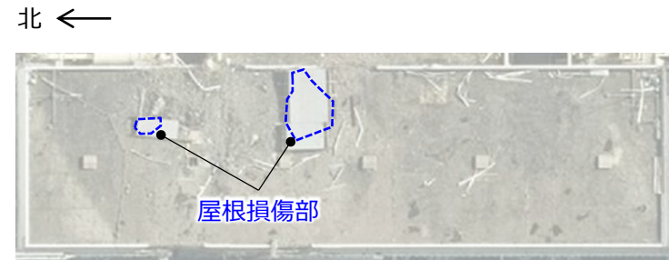
3号機タービン建屋・屋根状況【着手前】 〔上空から撮影〕
