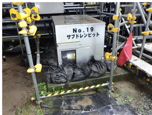
暫定対策後（7/14） （サブドレンNo.19ピット）
