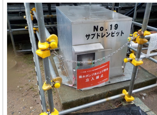
(サブドレンNo.19ピット) 4
