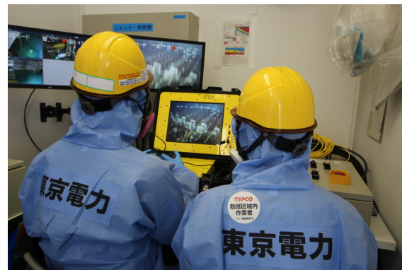
西側構台での水中ROV操作の様子 (調査作業)
