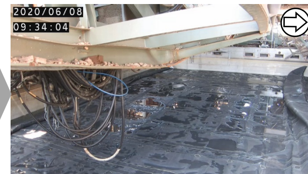
養生バグ展張（撮影日：2020.6.8）
