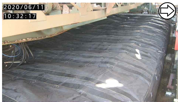
エアモルタル充填（撮影日：2020.6.11）
