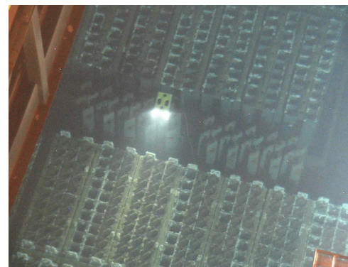
2号SFP内での水中ROV走行の様子
