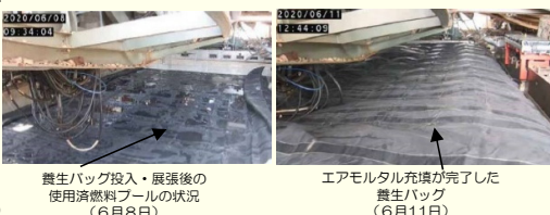
養生バック投入・展張後の使用済燃料プールの状況（6月8日）
