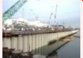
海側遮水壁 鋼管矢板打設完了状況
