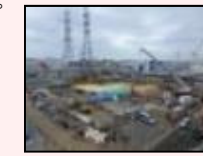
H1東エリア解体後の様子
