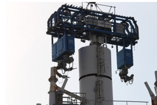
23ブロック目 解体作業状況(4月29日)
