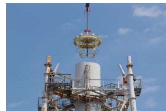
頂部蓋設置作業状況 (5月1日)
