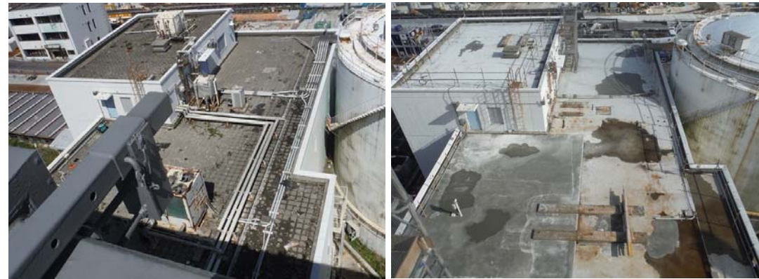
3,4号機増設S/Bガレキ撤去前
