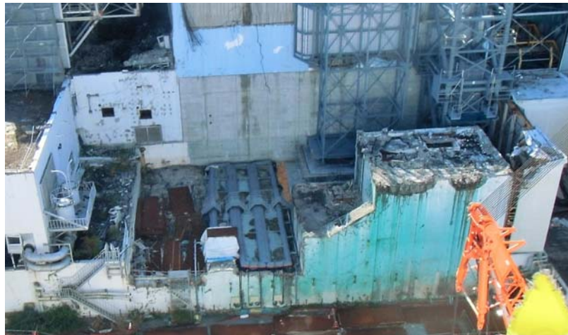
雨水対策、汚染源除去対策・着手前（2018年10月）
