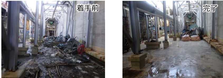
A工区 (2号機Rw/B側) 準備作業状況
