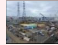
H1東エリア解体後の様子
