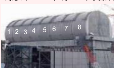
ドーム屋根設置状況 (2019/2/21撮影)
