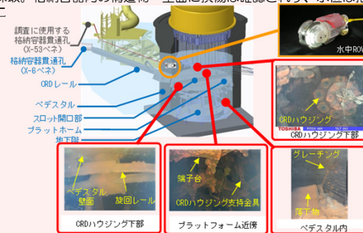
ベDESTAL内部の状況
