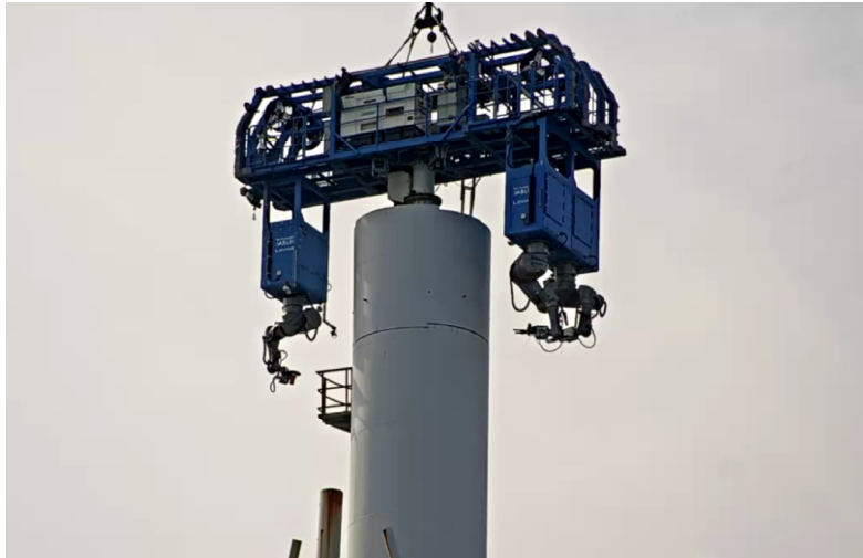
18ブロック目筒身解体作業(4月7日)
