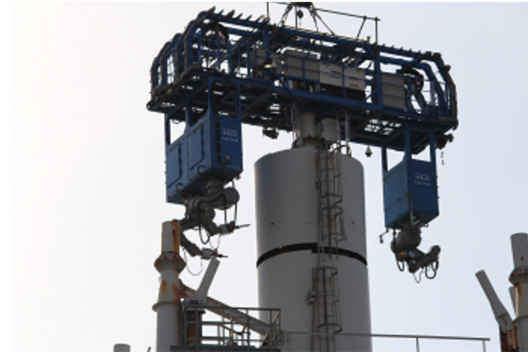
23ブロック目鉄塔解体作業状況(4月29日)
