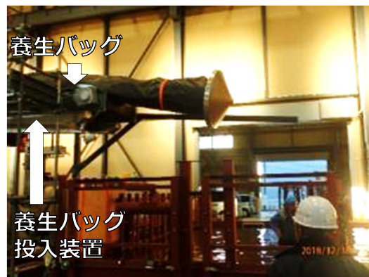
①養生バッグ投入
