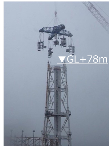
17ブロック解体中 (2020年3月29日)
