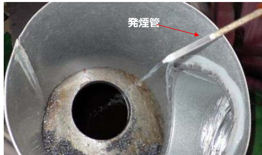
オフガス系配管穿孔状況 (φ100mm 穿孔後 気流確認)
