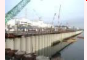
海側遮水壁 鋼管矢板打設完了状況
