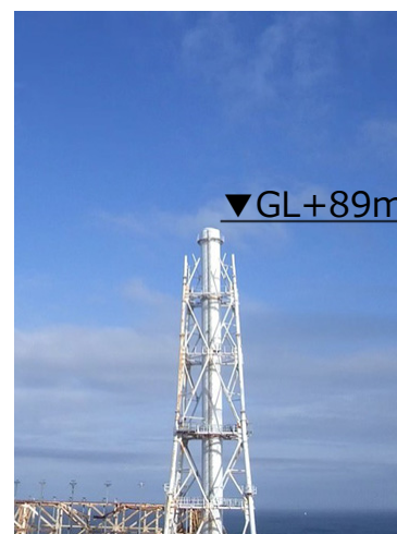
12ブロック解体後 (2020年3月9日)
