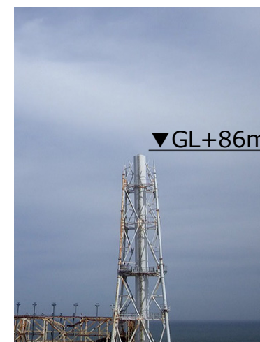
14ブロック解体後 (2020年3月13日)
