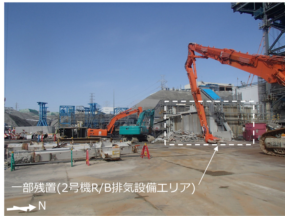
共用ボイラ建屋解体後(2020年3月撮影)
