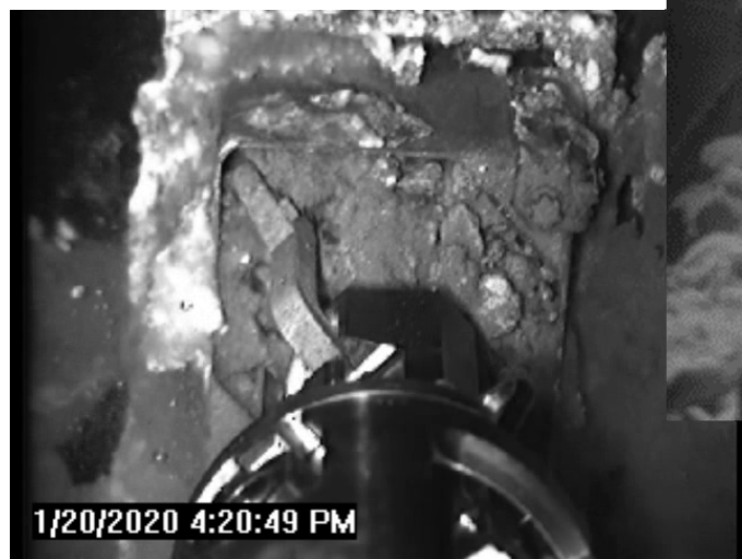
使用済燃料のラックからの取り出し状況
