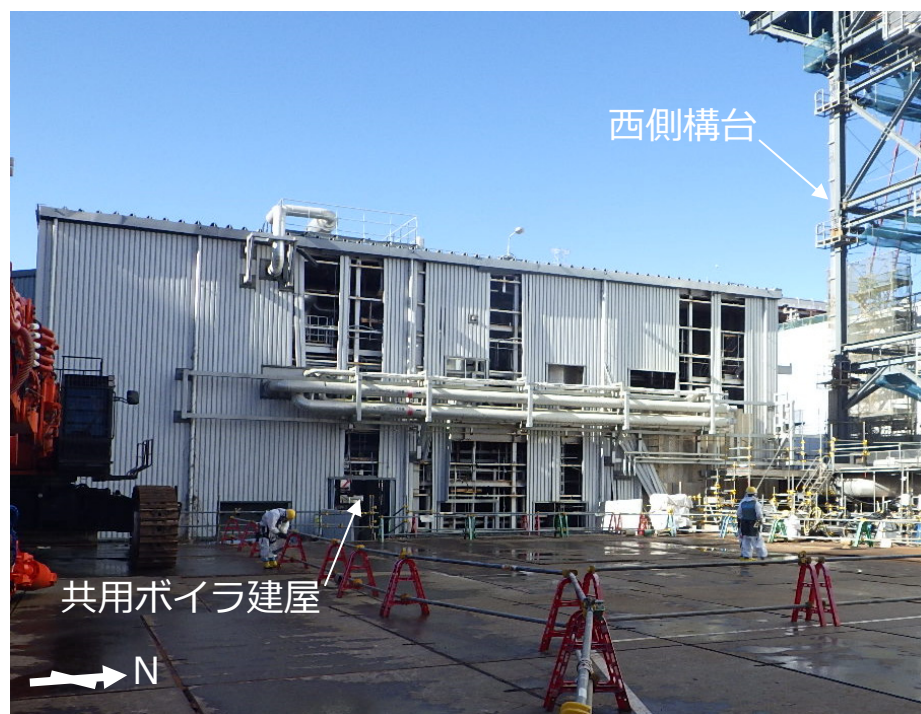
共用ボイラ建屋解体前 (2019年12月撮影)
