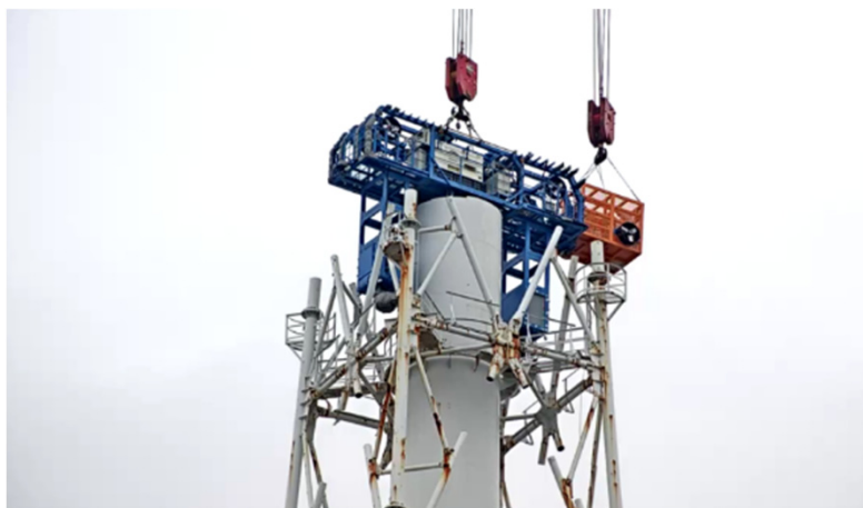
12ブロック目搭乗設備作業状況(2月26日)
