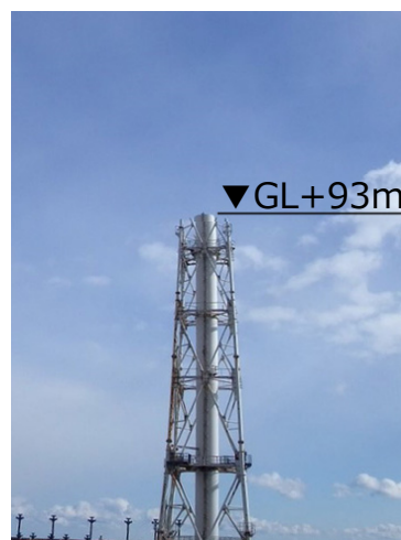
11ブロック解体後 (2020年2月4日)
