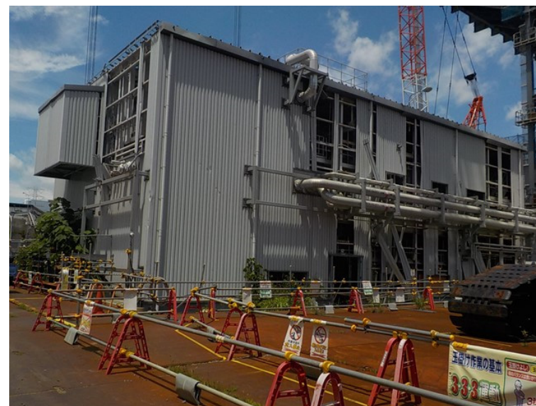
外観写真（南東側より）
