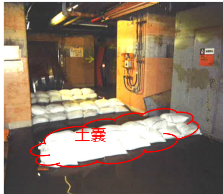
HTIの土嚢状態(設置時)
