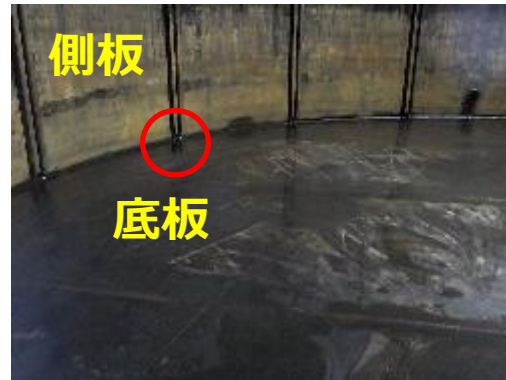
【参考】 同型タンク内面写真 (水抜き後)
