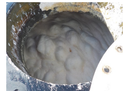
ブラインタンク内部状況 (1系統側) (2系統側)
