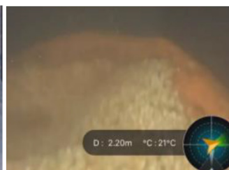
ゼオライト拡大写真(現在) ※土嚢袋が破れており、 中身が直接見える状況
