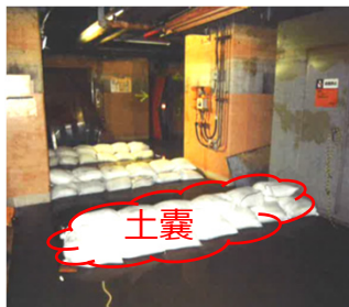
HTIの土嚢状態(設置時)
