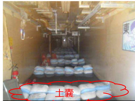
PMBの土嚢設置時の状態
