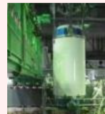
燃料取り出し状況
