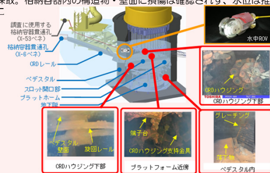
ベDESTAL内部の状況
