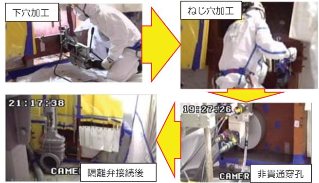
図1 隔離弁接続作業
