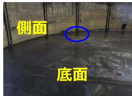
【参考】同型タンク内面写真（水抜き後）
