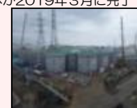
H1東エリア解体開始時の様子
