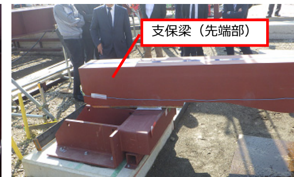
③支保梁挿入（完了）
