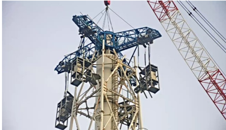
8ブロック目鉄塔解体作業(1月15日)
