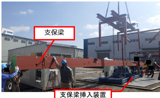
④矢板挿入装置の支保梁への設定
