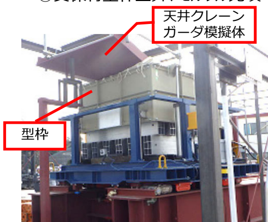
④支保材型枠上昇、モルタル充填
