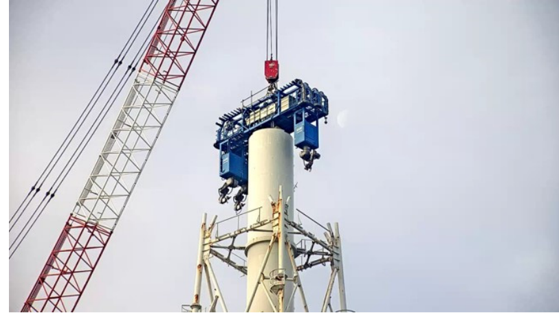
9ブロック目筒身解体作業(1月16日)
