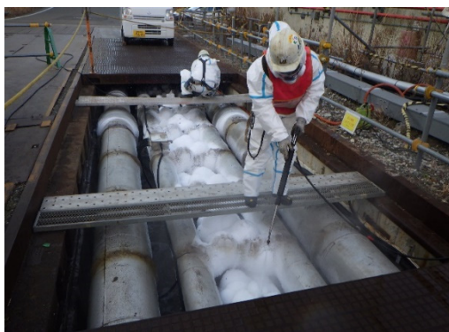
【冬季における路下部の氷着状況】 (写真は7BLK-H3の融氷作業中)
