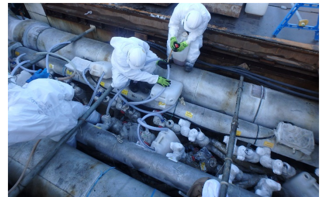
【加圧試験実施状況】
