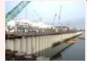
海側遮水壁 鋼管矢板打設完了状況
