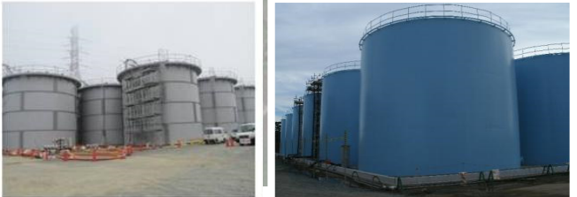
タンクの設置状況
