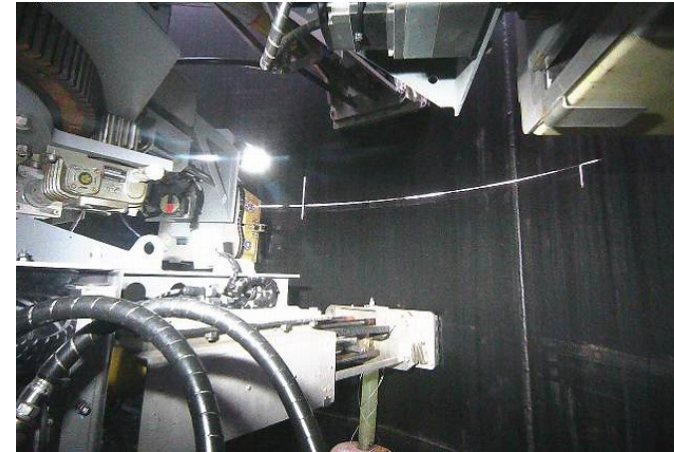
【写真⑥】 筒身切断状況 (12月18日)
