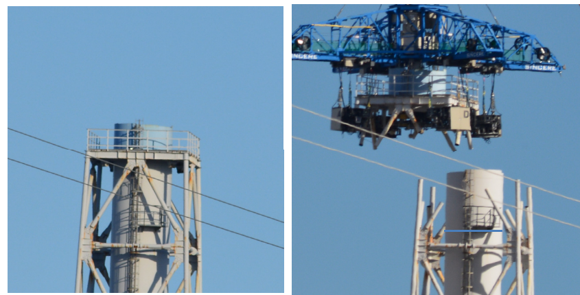
【写真⑧】 4ブロック目解体前後の比較
