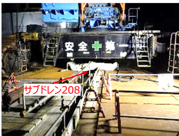
【写真⑦】クレーン移動前ヤード状況(12月4日)
