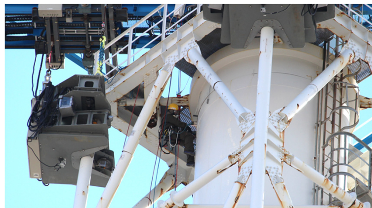
【写真⑥】 筒身切断状況 (12月4日)
