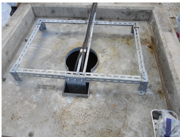
【写真⑤】復旧前状況(12月5日)
