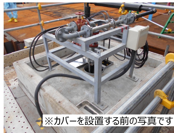
【写真⑥】復旧後状況(12月6日)
