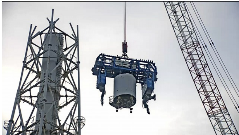
【写真⑦】 筒身吊り下ろし状況(12月19日)
