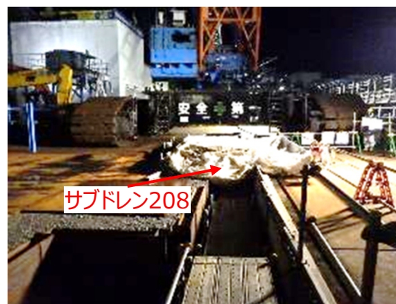
【写真⑧】クレーン移動後ヤード状況(12月4日)
