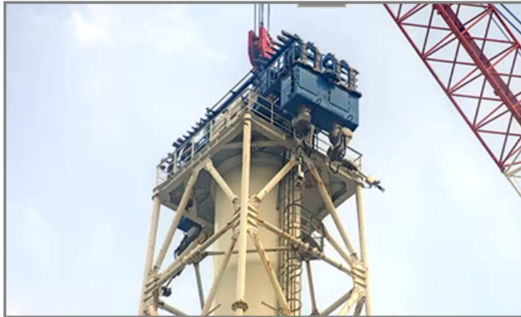
【写真①】筒身切断状況(10月27日)
