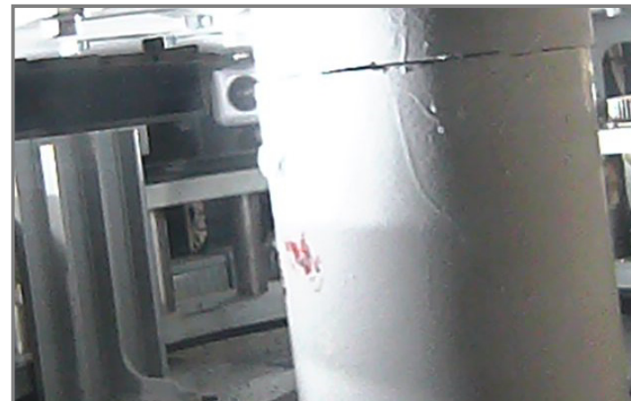
【写真④】主柱材切断状況(11月26日)
