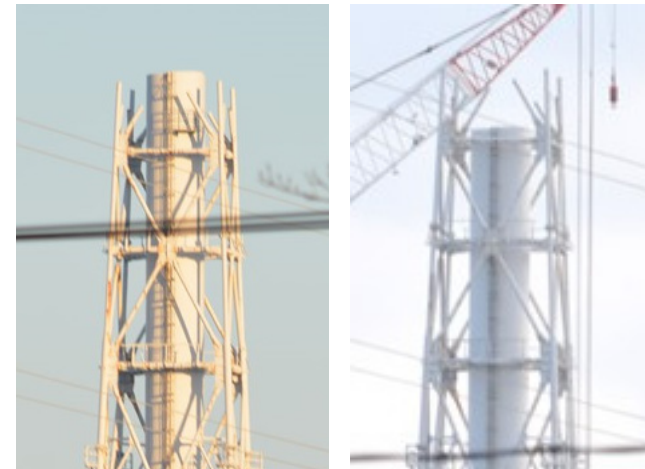
【写真⑧】 5ブロック目解体前後の比較
