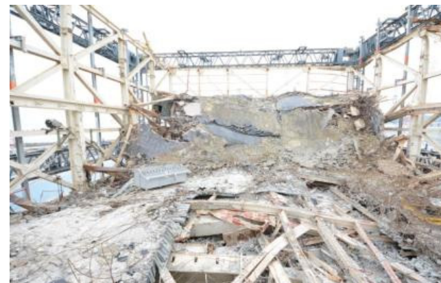
南側崩落屋根の状況
