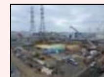
H1東エリア解体後の様子
