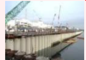
海側遮水壁 鋼管矢板打設完了状況
