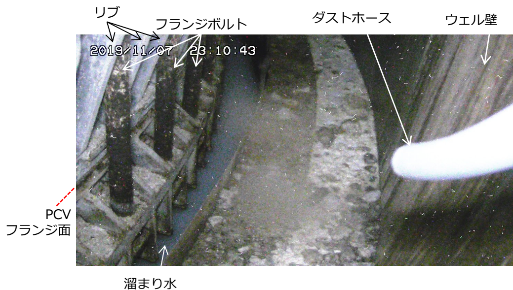
①ダストホース設置状況
