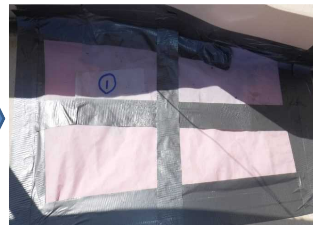
③ビニール養生
