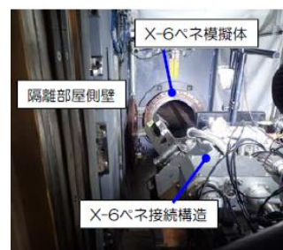
隔離部屋内作業(X-6ペネ近傍) 組合せ試験の状況
