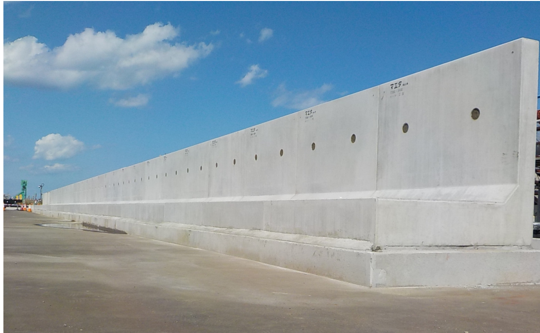
現地据付状況 (9月25日撮影)
