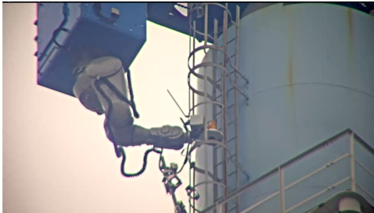
【写真⑤】 付属品切断状況(9月18日)
