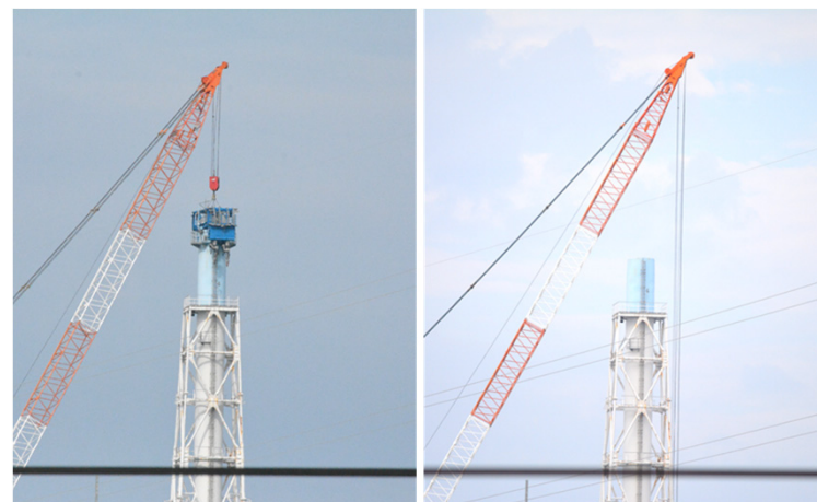
【写真④】解体前後の比較（9月1日）
