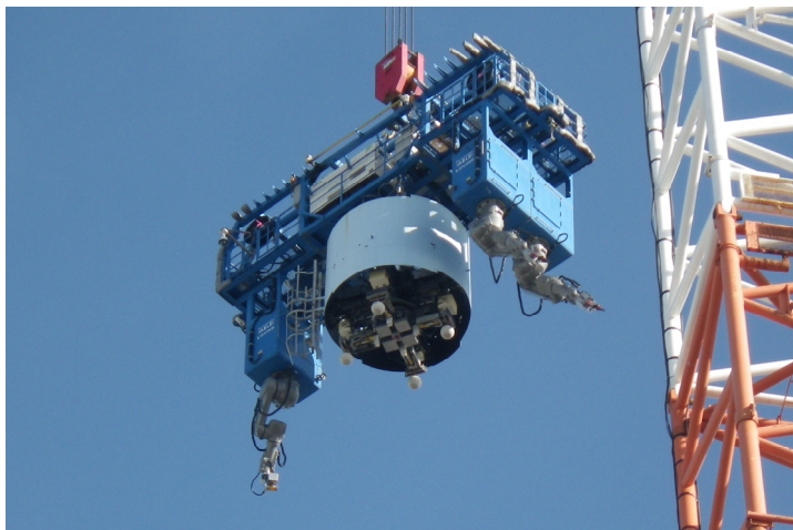
【写真⑦】 吊り下ろし状況(9月26日)
