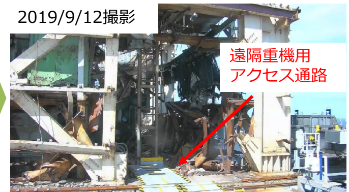
南側小ガレキ撤去後
