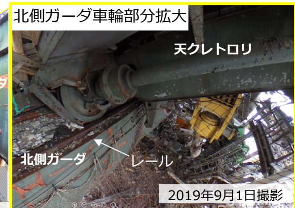
2019年9月1日撮影 北側ガーダ車輪部分拡大
