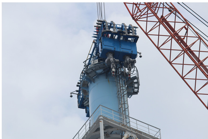
【写真①】切断作業状況・外側(9月1日)
