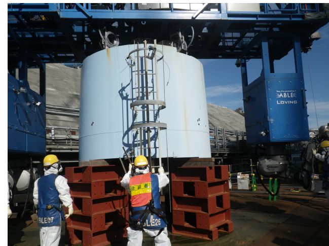
【写真⑧】 吊り下ろし後 (9月26日)
