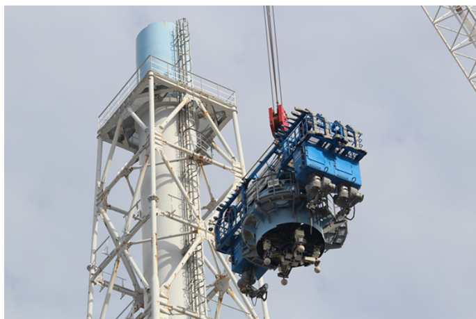
【写真③】吊り下ろし状況(9月1日)
