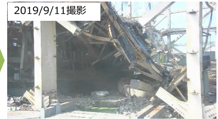
SFP上の鉄骨撤去後
