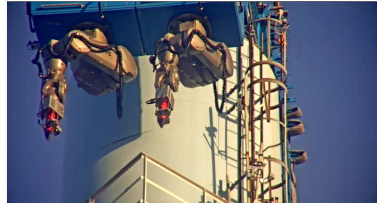
【写真⑥】 筒身切断状況 (9月18日)
