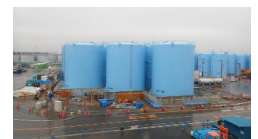
(溶接型タンク設置状況)
