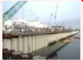
海側遮水壁 鋼管矢板打設完了状況
