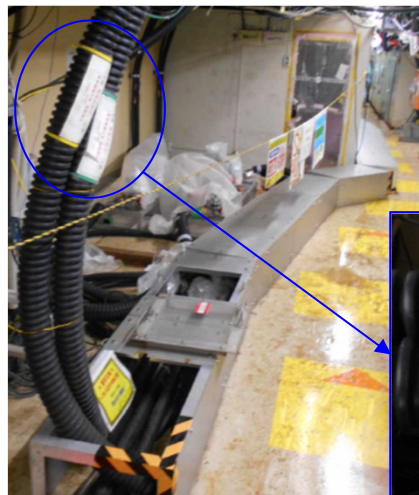
金属トラフ入口側
