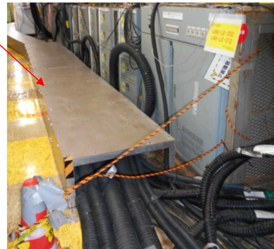
金属トラフ出口側
