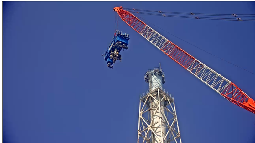
【写真①】 解体装置の設置状況 (8月1日)
