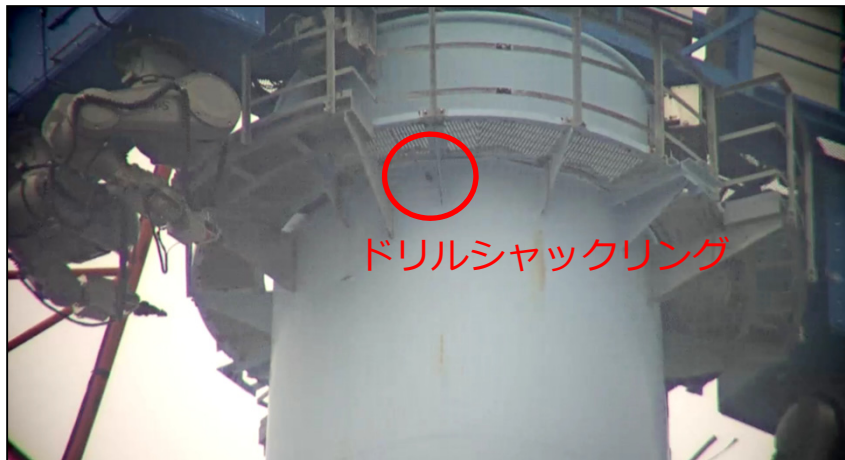
【写真③】 ドリルシャックリング設置状況(8月7日)
