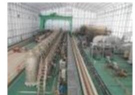
(高性能多核種除去設備)
