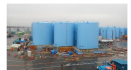
(溶接型タンク設置状況)
