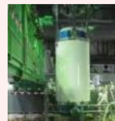
燃料取り出し状況
