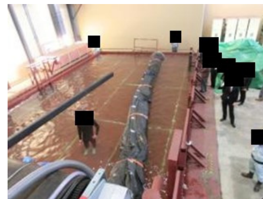
③バッグ投入完了
