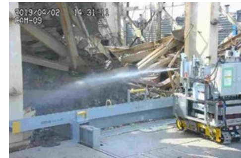
飛散防止剤散布状況
