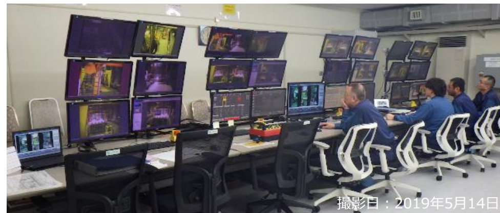
遠隔操作室の状況
