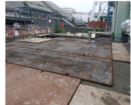
④ 敷鉄板設置
