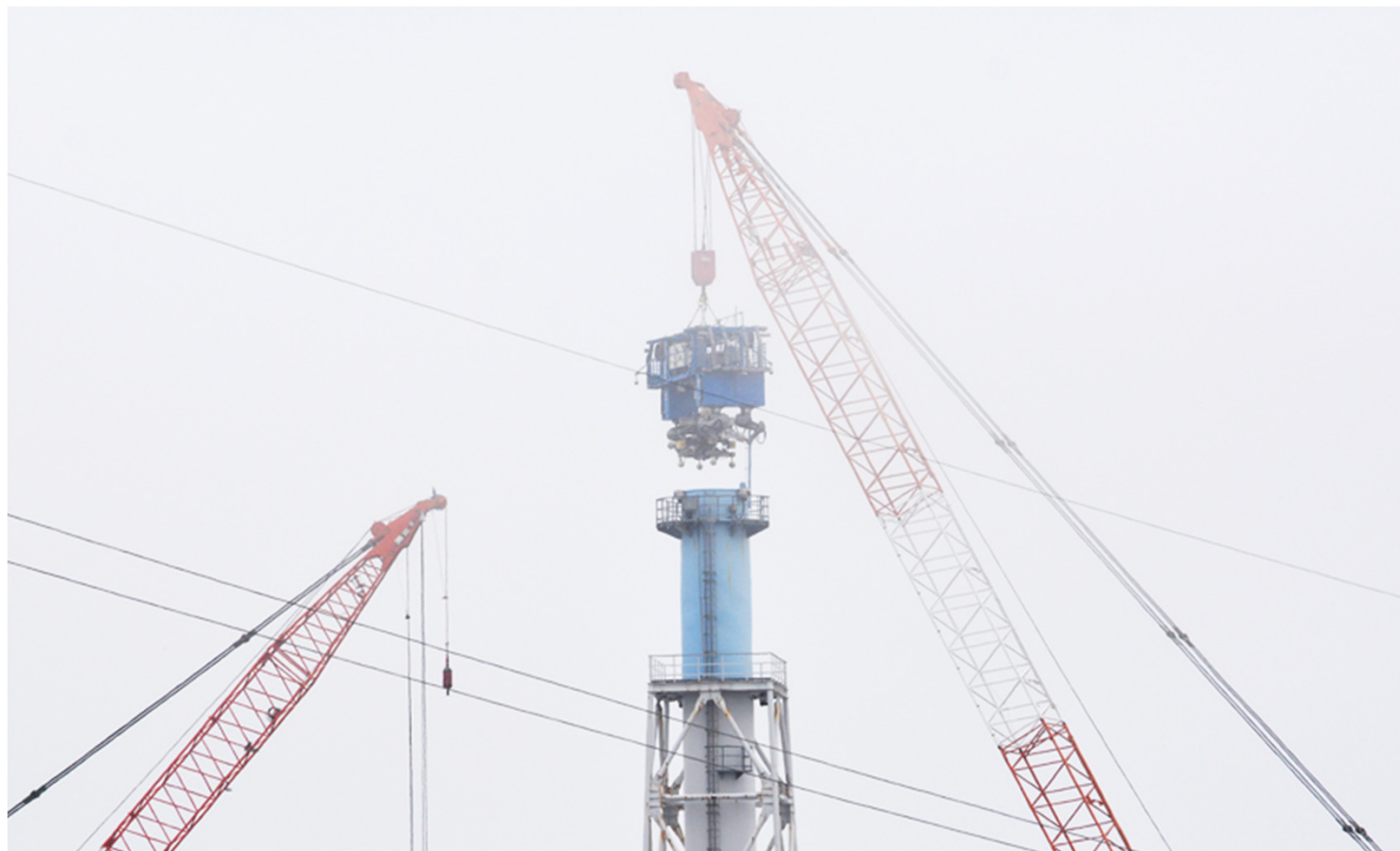
クレーン高さ確認の作業状況
