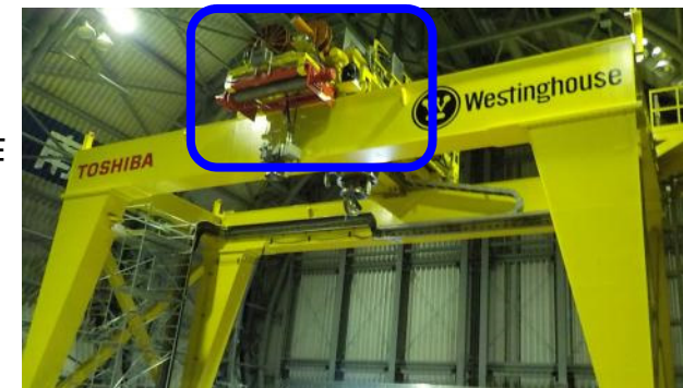
クレーン（○部：補巻）
