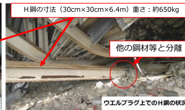
撤去対象 (H鋼) の全体状況
