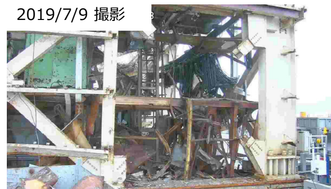
小ガレキ撤去後
