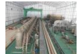
(高性能多核種除去設備)
