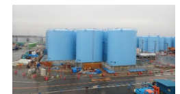
(溶接型タンク設置状況)
