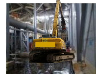
遠隔解体重機
