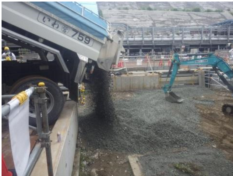
路盤整備状況（碎石搬入）撮影日：6/11
