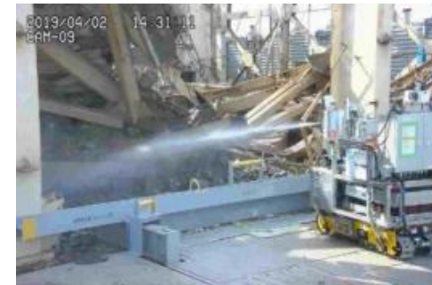
飛散防止剤散布状況
