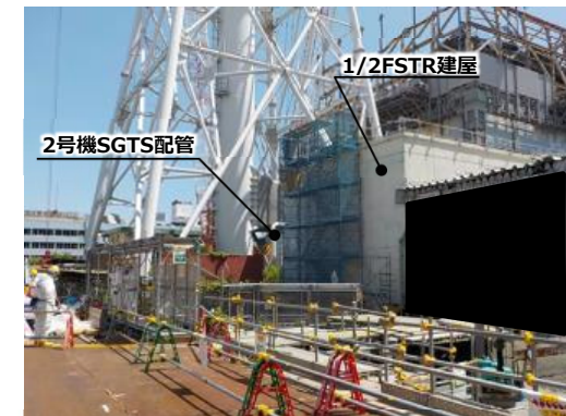
写真② クレーン設置予定場所の西側道路から排気筒方面を撮影 (SGTS配管がわずかに視認できるが雰囲気線量は変わらない)
