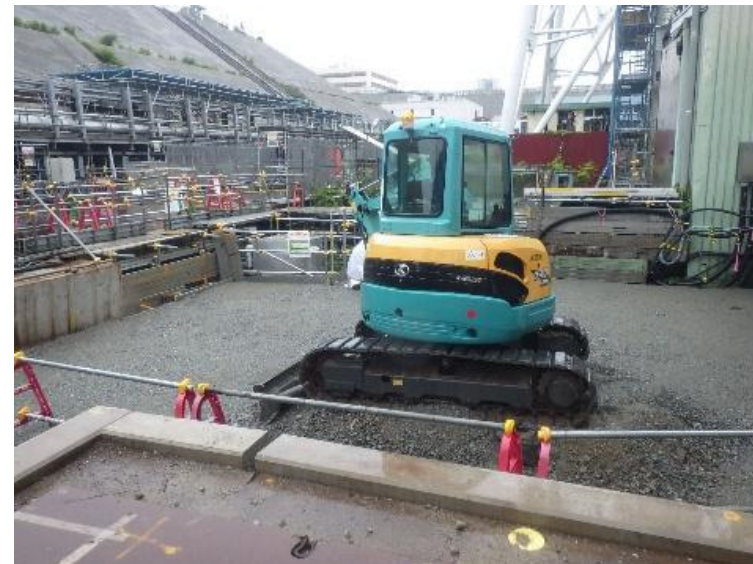
路盤整備状況（整地）撮影日：6/15
