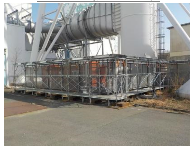
5 / 6号機排気筒：北側
