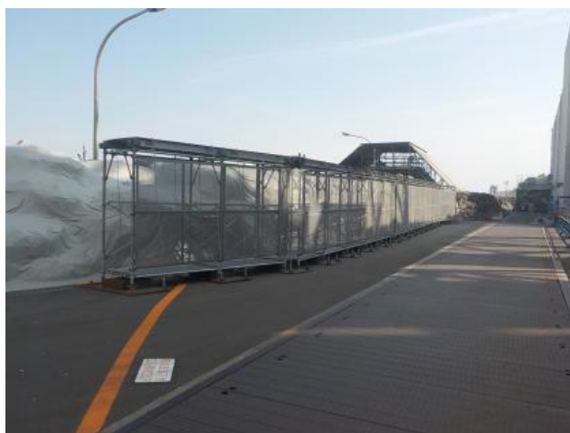
タービン建屋集中排気筒：東側
