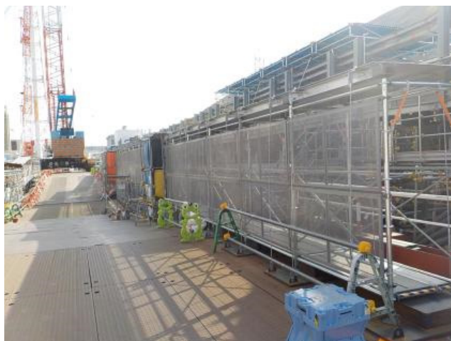
1 / 2号機排気筒：西側
