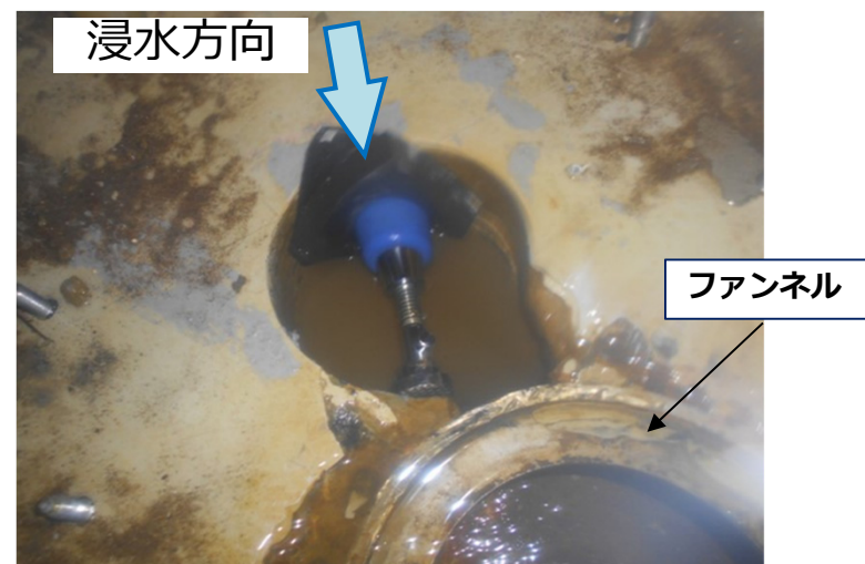
コア抜き箇所の流入抑制状況
