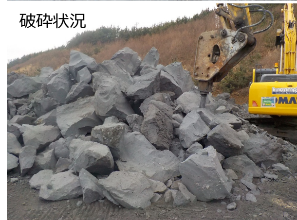
写真④：人工地盤材料製造状況
