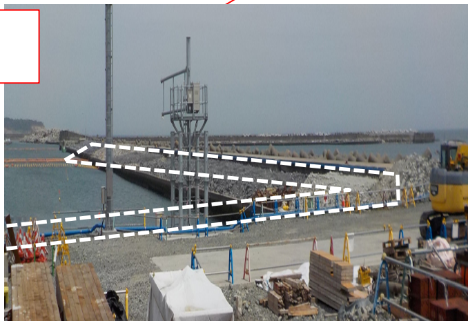
写真⑤ バラスト水移送準備 PE管移送ルート
