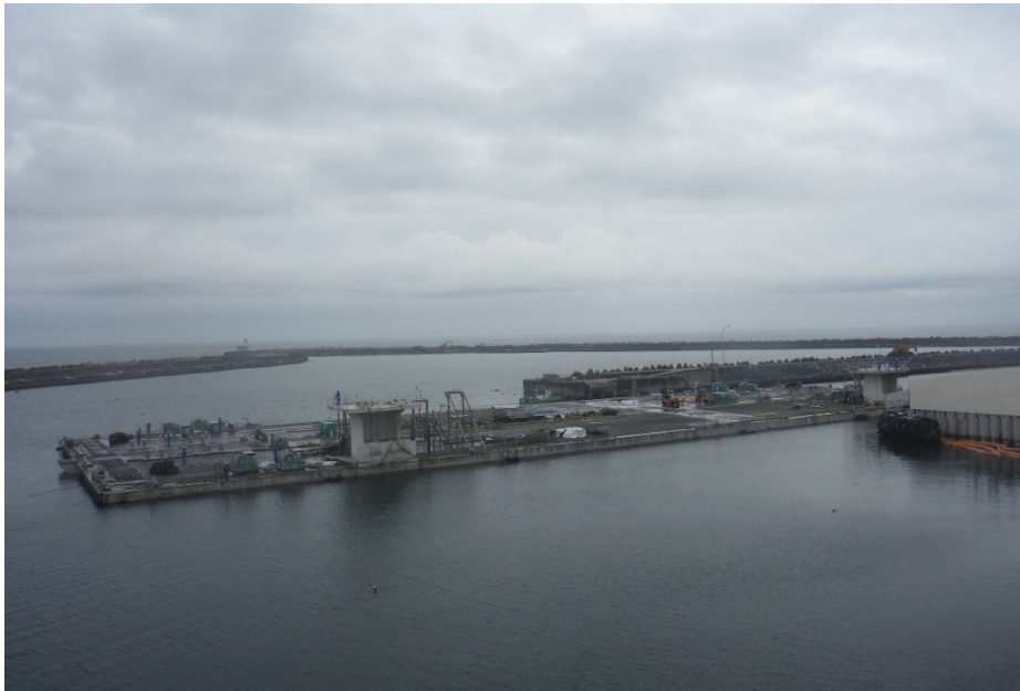
写真①: 1 - 4号機取水路開渠への移動 2019年5月15日
