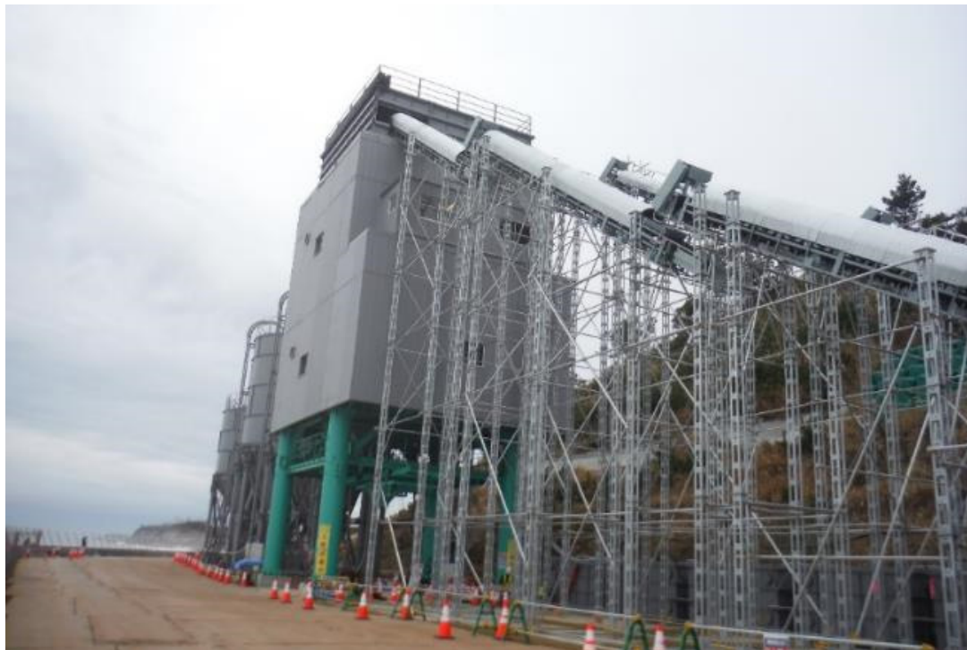
写真③：製造プラント全景
