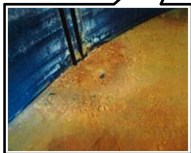
スラッジ回収前
