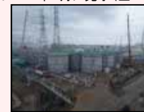
H1東エリア解体開始時の様子
