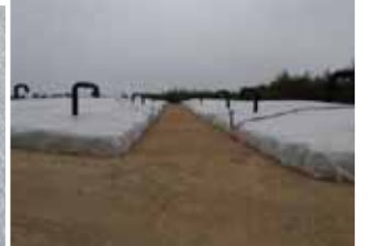
伐採木一時保管槽
