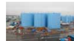
(溶接型タンク設置状況)
