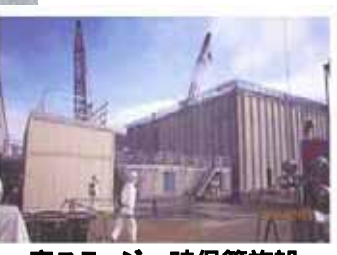
廃スラッジ一時保管施設
