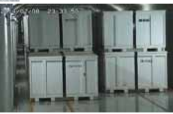
固体廃棄物貯蔵庫
