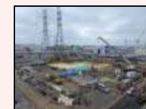
H1東エリア解体後の様子
