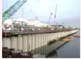
海側遮水壁 鋼管矢板打設完了状況
