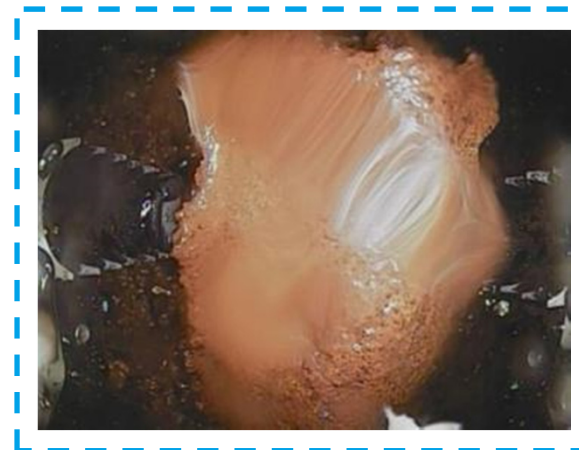
底部-6の調査状況 調査日：2019年2月13日
