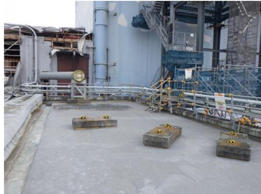
FSTR建屋片付け状況
