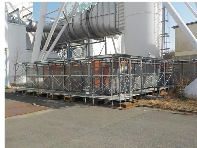
5 / 6号機排気筒：北側
