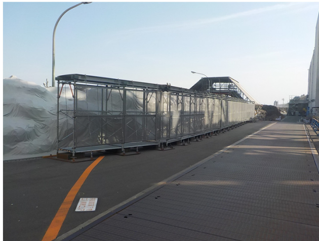
タービン建屋集中排気筒：東側
