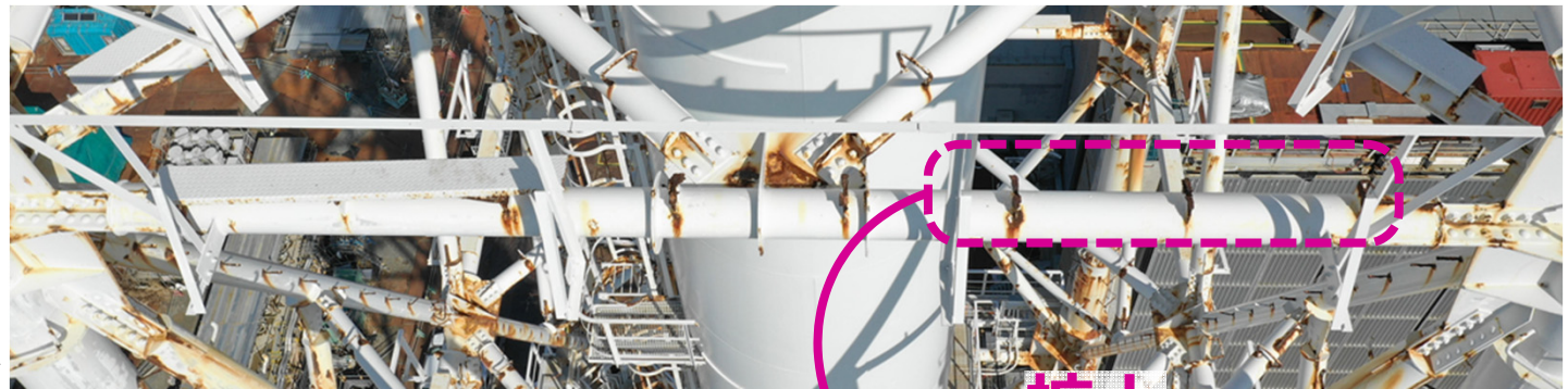
【写真①】 地上約76mの南側水平材
