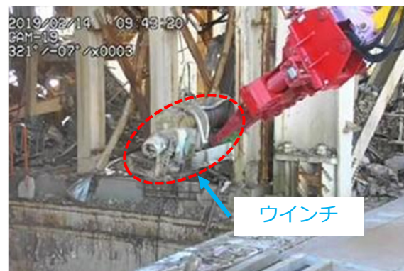
ウィンチ撤去の様子 ※ガレキ撤去ツールのペンチを使用
