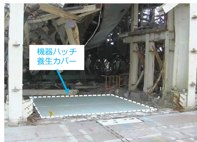
機器ハッチ養生カバー設置後（西作業床より）
