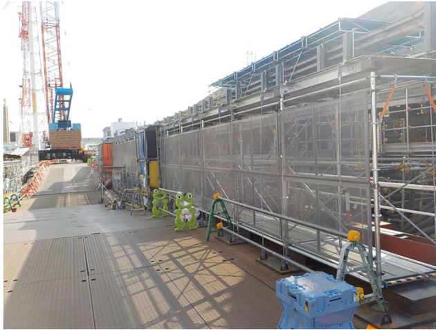
1 / 2号機排気筒：西側
