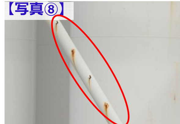
劣化が疑われるステップ 南面 地上32m付近
