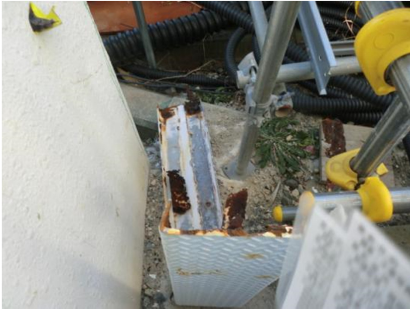
落下した足場材
