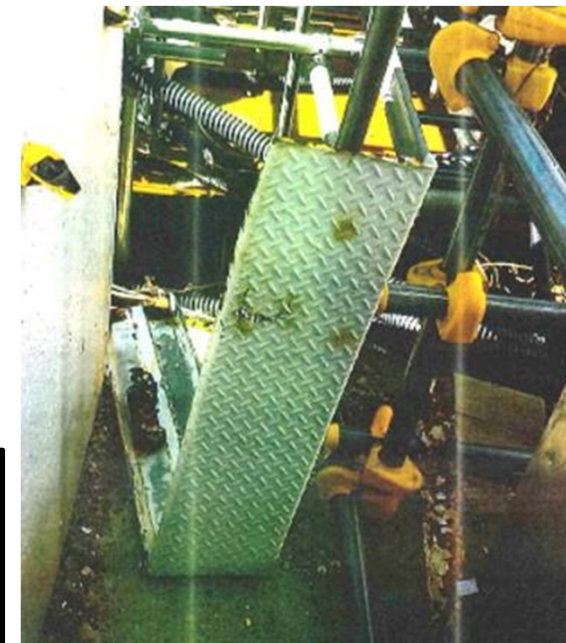
落下した点検用の足場
