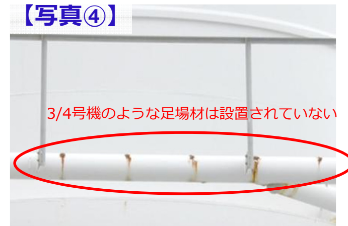
5/6号機の水平材 (鉄塔) 南面 地上76m付近
