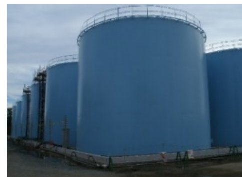
ALPS処理水タンク (溶接型タンク) 新設・リプレース (Bエリア)
