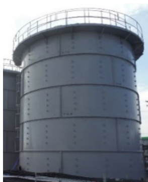
ALPS処理水タンク (フランジ型タンク) 水抜き・解体 (G4北、G5エリア)
