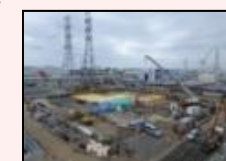
H1東エリア解体後の様子
