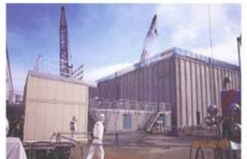
廃スラッジ一時保管施設
