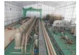
(高性能多核種除去設備)
