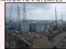
H1東エリア解体開始時の様子
