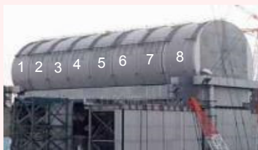
ドーム屋根設置状況 (2/21撮影)
