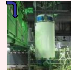
燃料取り出し状況
