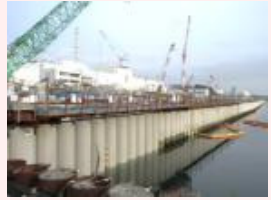
海側遮水壁 鋼管矢板打設完了状況
