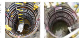
(陸側遮水壁) 内側 (陸側遮水壁) 外側
