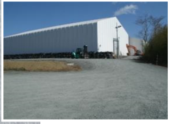
瓦礫保管テント
