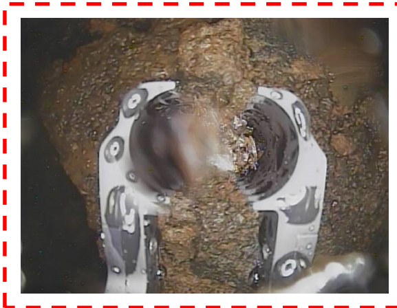
プラットフォーム上-1の調査状況
