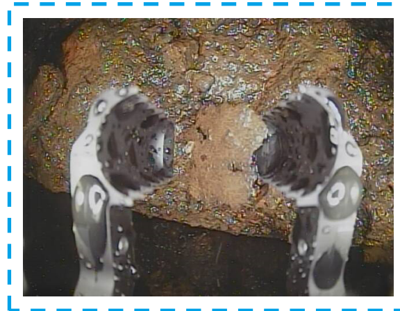
プラットフォーム上-4の調査状況
