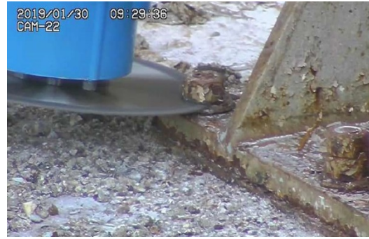
ボルト・ナット切断の様子 (拡大)
