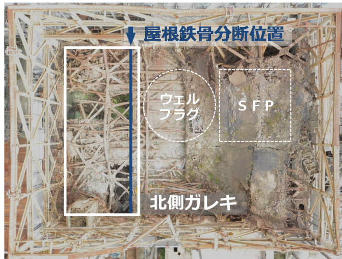
屋根鉄骨分断位置
