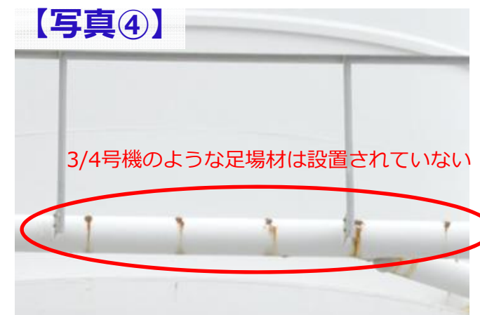
5/6号機の鉄塔 南面 地上76m付近
