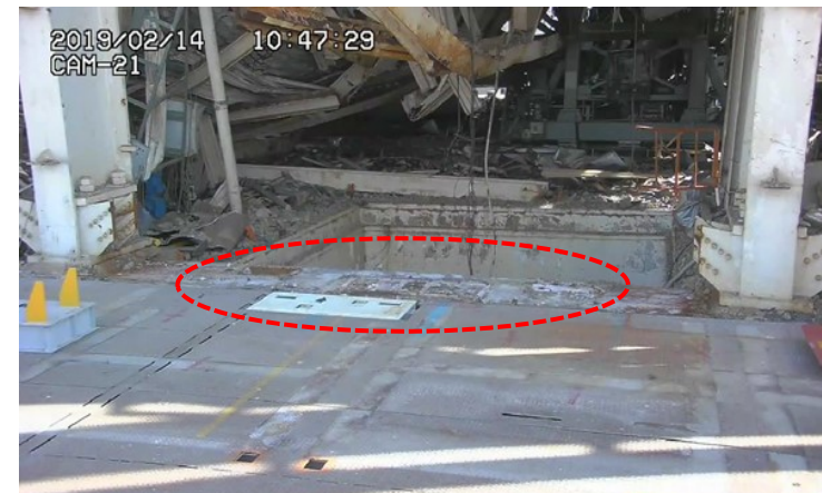
ウインチ・ヒンジ撤去後
