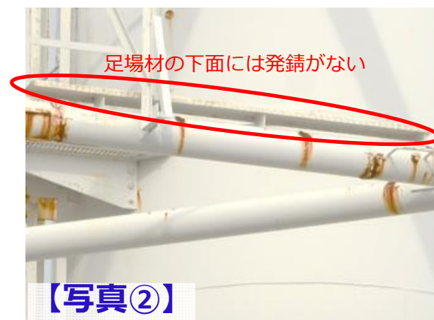
3/4号機 健全と推定される足場材 北面 地上18m付近
