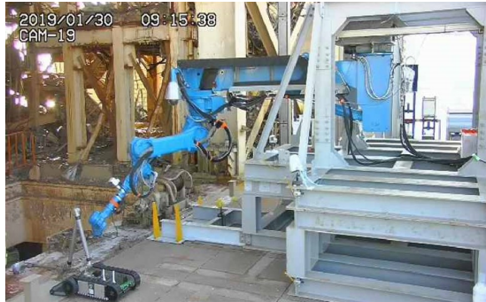
ボルト・ナット切断の様子
