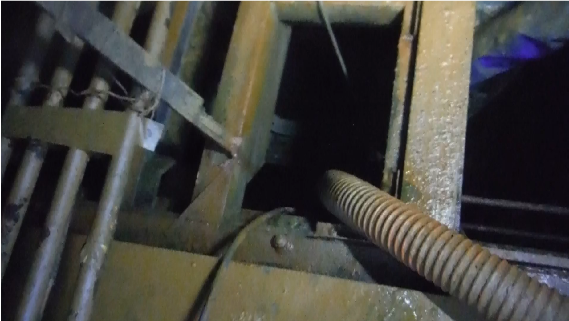
サンプタンク流入状況
