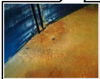
スラッジ回収前
