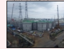
H1東エリア解体開始時の様子
