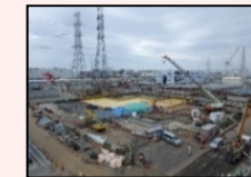
H1東エリア解体後の様子
