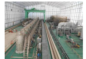
(高性能多核種除去設備)
