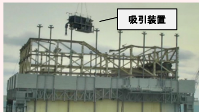
<進捗状況(1/22撮影)>
