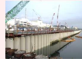
海側遮水壁 鋼管矢板打設完了状況
