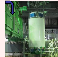
燃料取り出し状況
