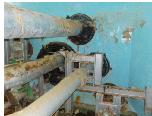
①配管ダクト内の状況
