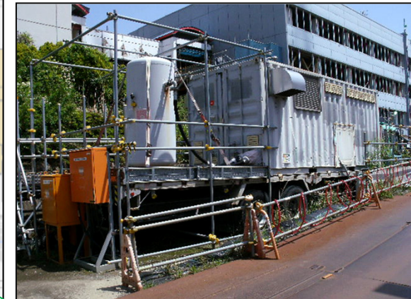
窒素ガス分離装置A T.P.8.5m盤
