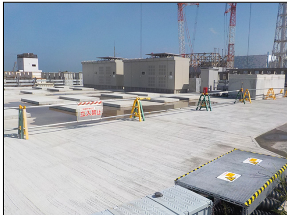
高台の新設エリア T.P.33.5m盤
