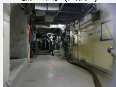
【撤去後】(矢視C)
