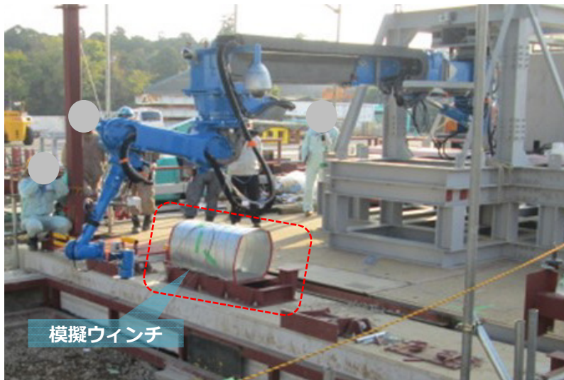
ロボットアームによる作業
