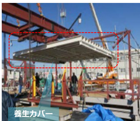
養生カバー搬入
