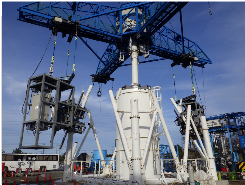
斜材切断の状況
