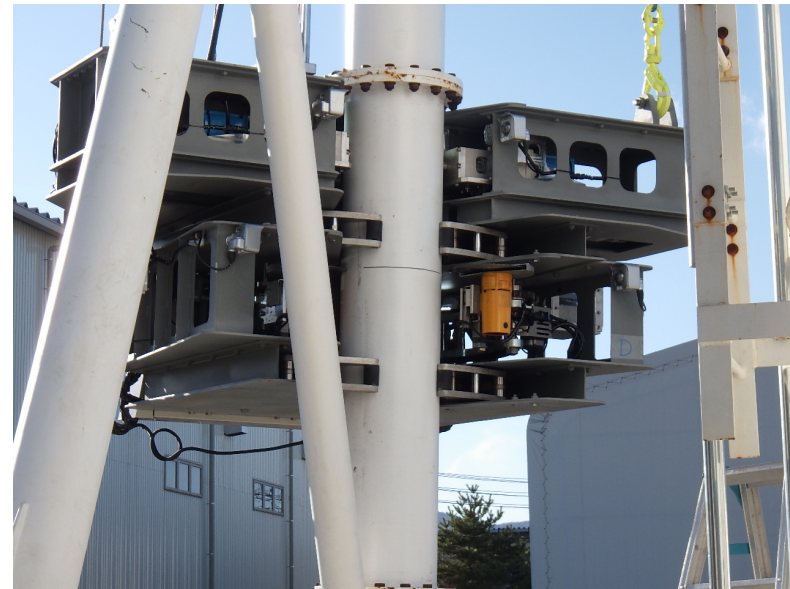
主柱切断作業の状況
