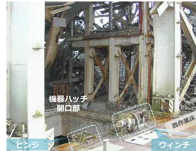
機器ハッチの状況（西作業床より）
