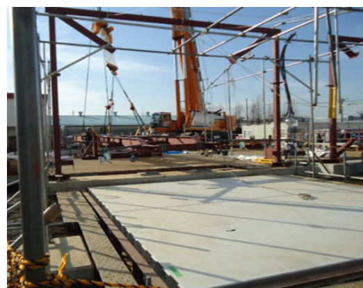
養生カバー設置完了
