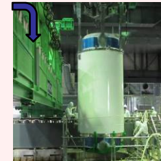
燃料取り出し状況
