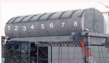
ドーム屋根設置状況 (2/21撮影)
