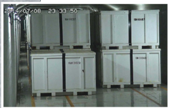
固体廃棄物貯蔵庫
