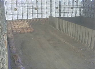
瓦礫保管 テント内
