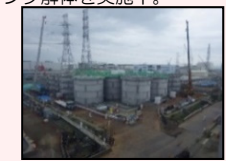
H1東エリア解体開始時の様子
