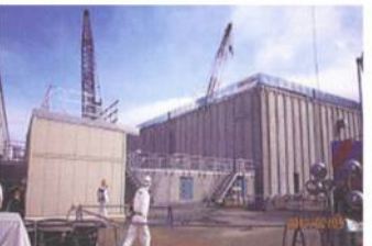
廃スラッジ一時保管施設
