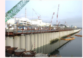
海側遮水壁 鋼管矢板打設完了状況
