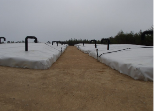
伐採木一時保管槽
