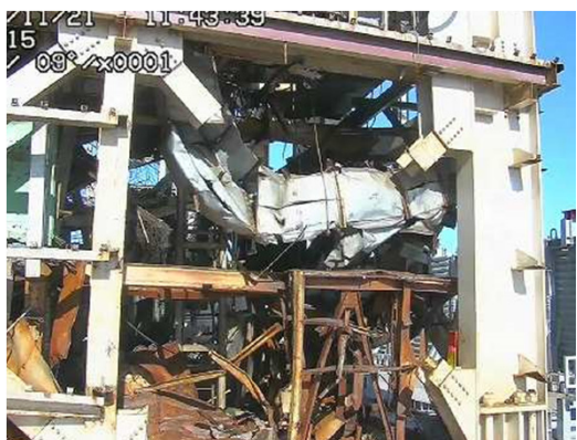
撤去後の南面（11月21日）
