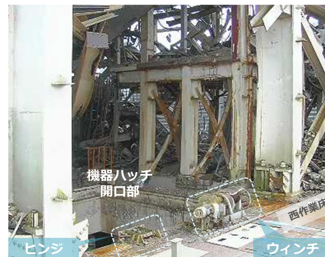
機器ハッチの状況（西作業床より）
