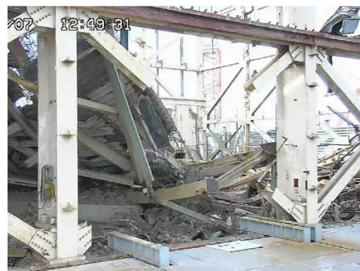
撤去後の東面1（12月7日）
