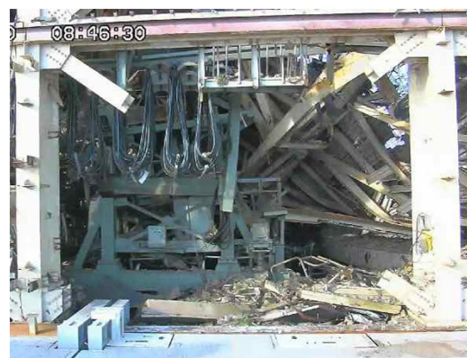
撤去後の東面2（12月20日）
