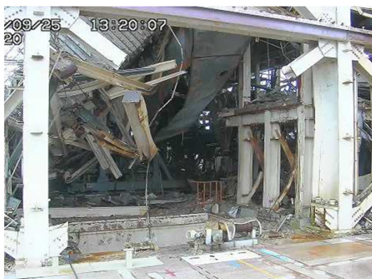
撤去後の西面（9月25日）
