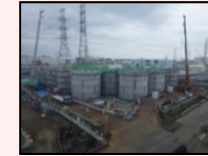
H1東エリア解体開始時の様子
