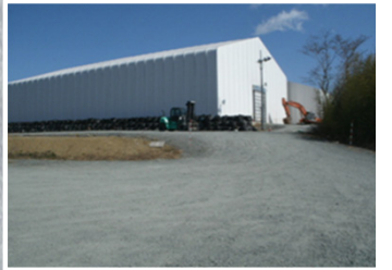
瓦礫保管テント
