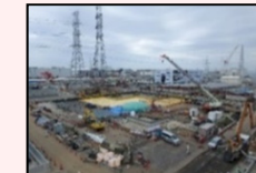
H1東エリア解体後の様子
