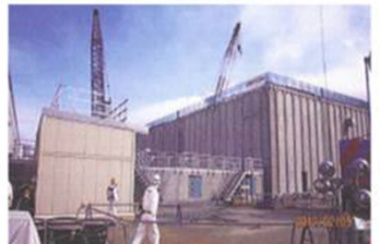
廃スラッジ一時保管施設
